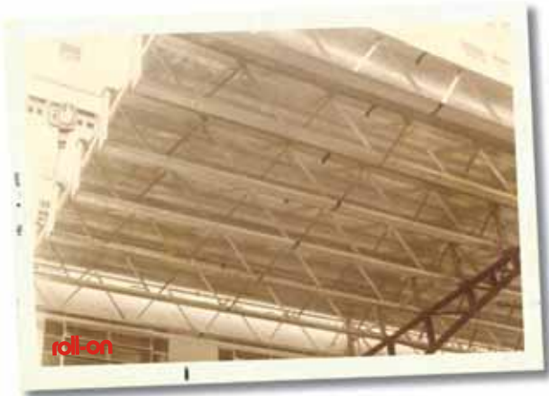
Cobertura DNER-RJ, 180m 2 , 1979. Primeira obra onde foi especificado o Sistema de Cobertura Roll-on. A cobertura permanece inalterada até hoje.
