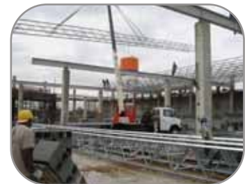
6. Rapidez na elevação 6. Modules rising 6. Elevación de los módulos
